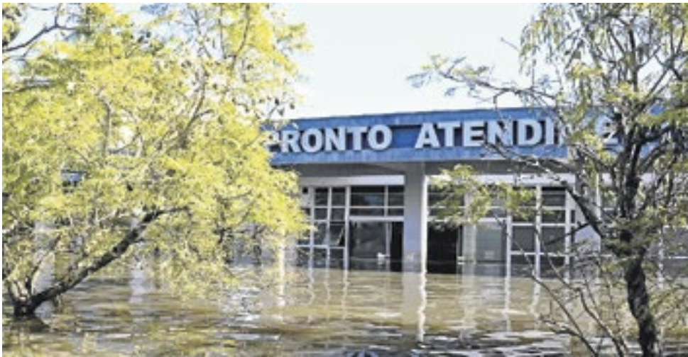
Símbolo da tragédia, Hospital de Pronto Socorro de Canoas foi gravemente atingido
