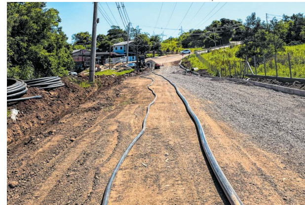
Primeira etapa da obra foi iniciada nesta segunda-feira e compreende trecho da Rua Uruguai até a Rua Pejuçara
