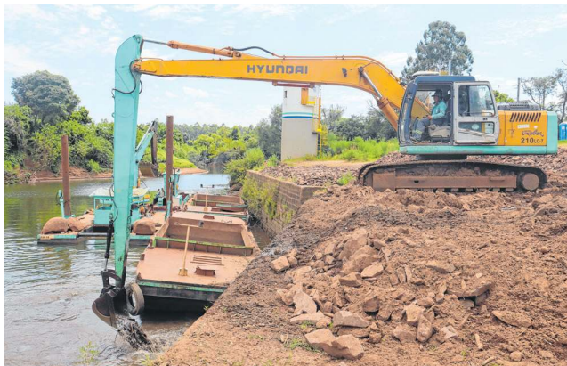
Desassoreamento do Rio Cai vai levar de três a quatro meses
