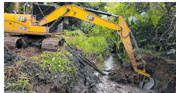
Serviço é realizado em trecho do Arroio Paradiso
