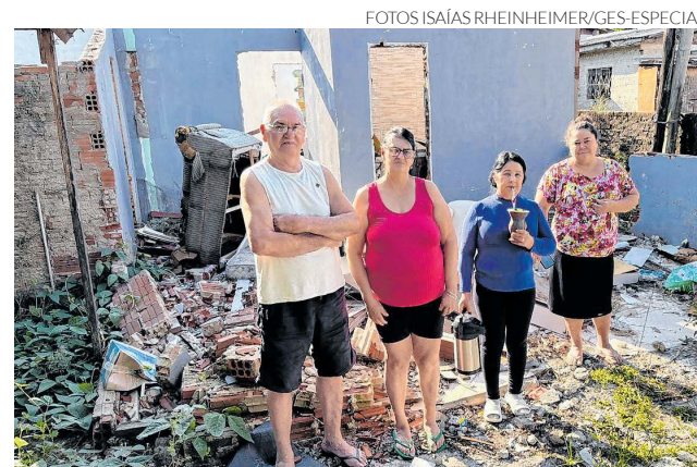
Moradores se uniram para reclamar da situação do local
