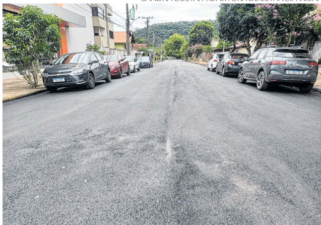
Trecho pavimentado tem cerca de 440 metros de extensão
