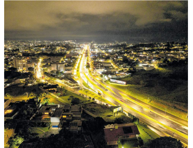
Trecho da 239 em Saporanga receberá iluminação em LED
