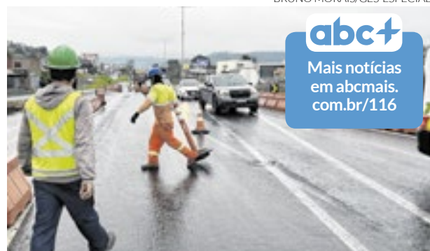
Sinalizações conduzem trecho para faixa única
