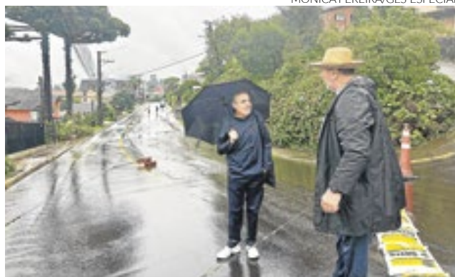
Fissura no asfalto na Rua Henrique Bertoluci
