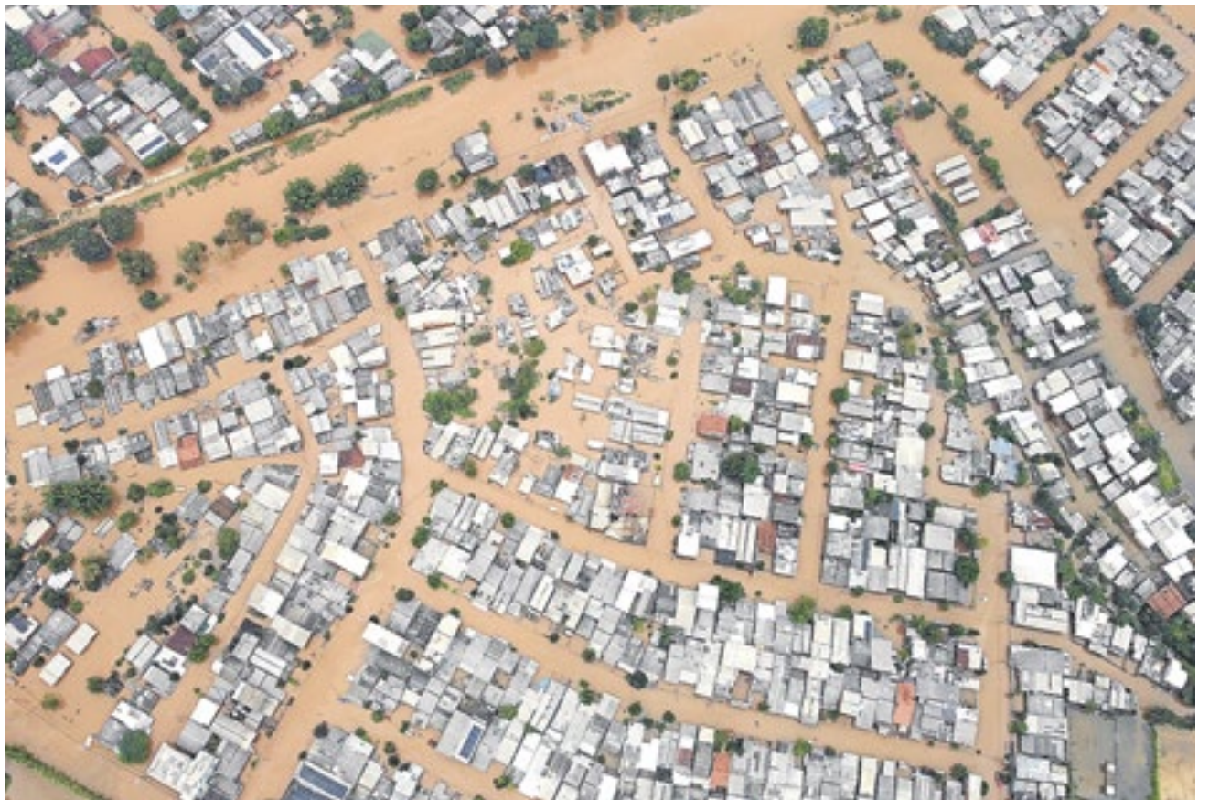
Inundação, no fim de semana, na parte mais baixa do bairro Santo Afonso, em Novo Hamburgo
