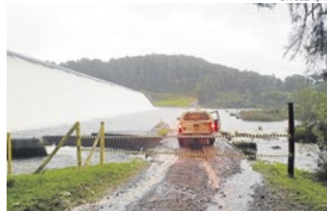
Barragem do Blang teve passagem de veículos fechada
