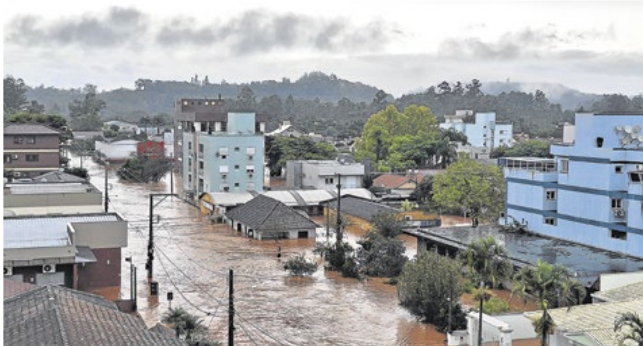
Rio invadiu ruas de S. Sebastião do Caí e deixou população ilhada, situação agravada pelo temor de rompimento de barragens
