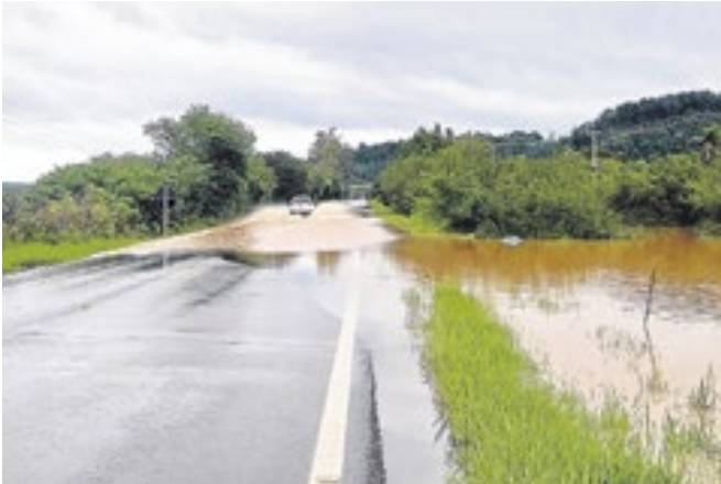
Rodovias têm água na pista, crateras e outros problemas
