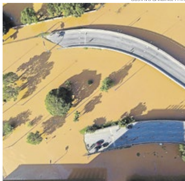
Vias da capital estão obstruídas pela elevação das águas
