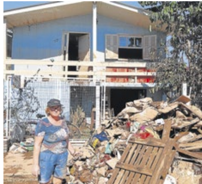
Casa de Elfrida Weber foi condenada pela força do Rio Caí
