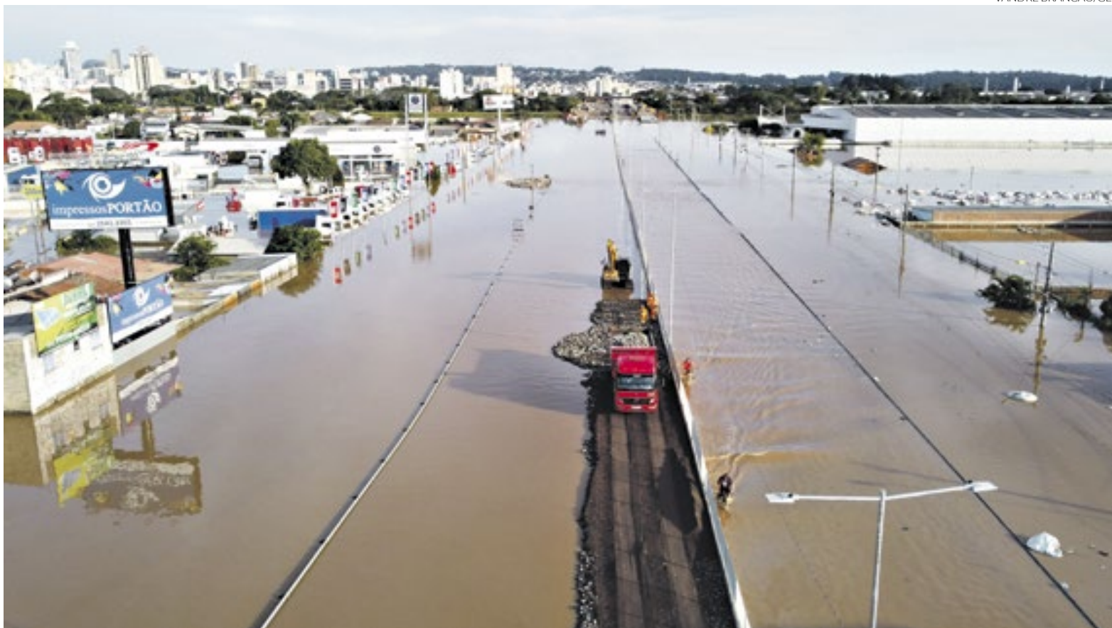
Dnit trabalha em caminho alternativo em meio às águas da BR-116 para tentar conectar Novo Hamburgo e São Leopoldo
