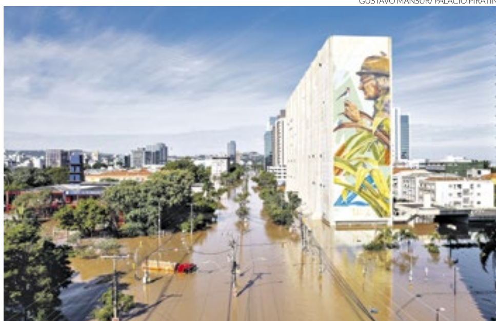
Novos pontos da capital foram atingidos pelas águas após problemas em casas de bomba
