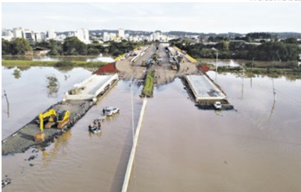
Dnit está construindo caminho alternativo com pedra rachão, que evita represamento
