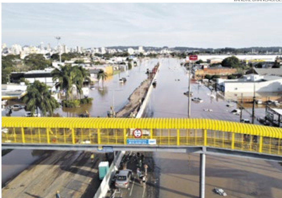
Trabalho ocorre em dois pontos: Passarela Caxias do Sul e Viaduto João Corrêa
