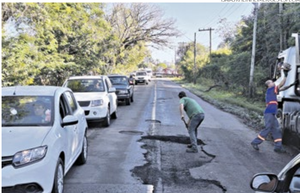
Operação tapa-buraco emergencial na Estrada da Integração Leopoldo Petry
