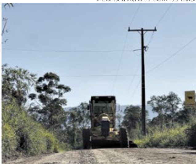
Secretaria de Obras atua na limpeza das estradas
