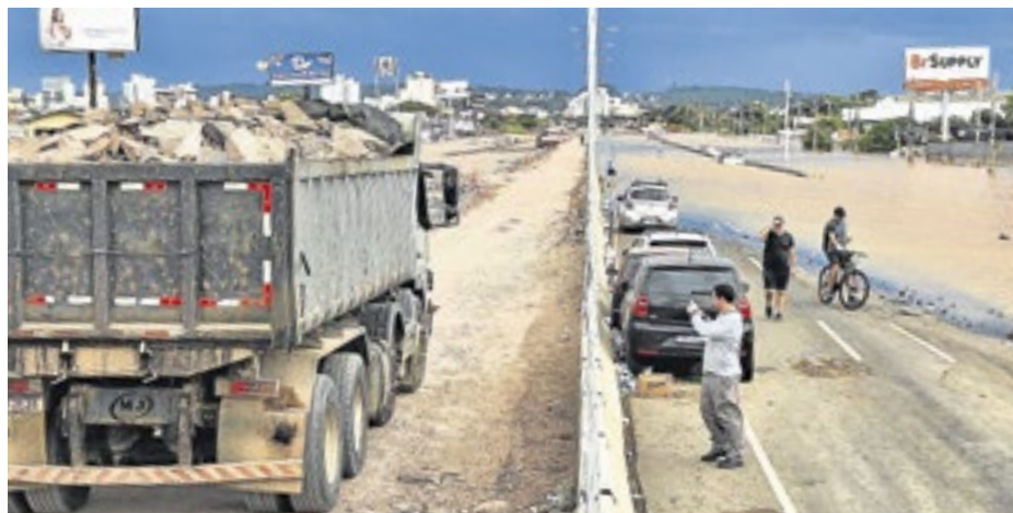
Pista construída emergencialmente na BR-116 a partir da Passarela Caxias do Sul às pontes
