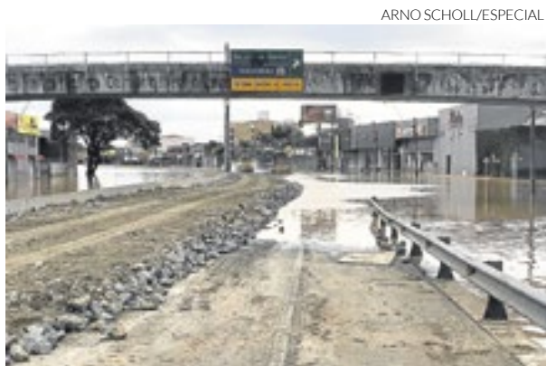
Obra a partir do viaduto da João Corrêa em direção à ponte
