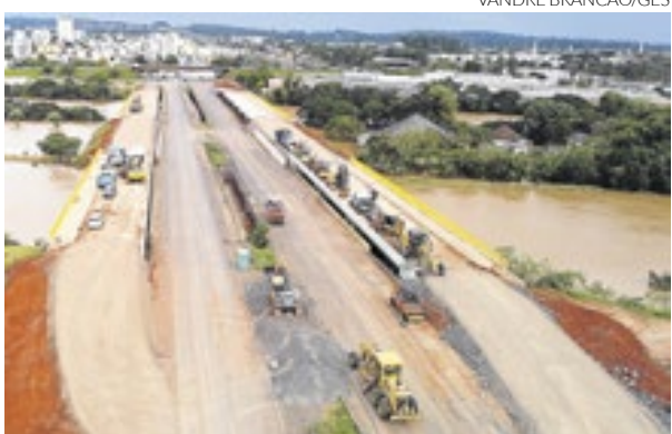
Novas pontes sobre o rio ganharam acessos emergenciais
