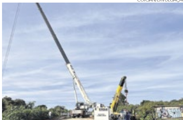
Guincho utilizado para manter tubulação suspensa
