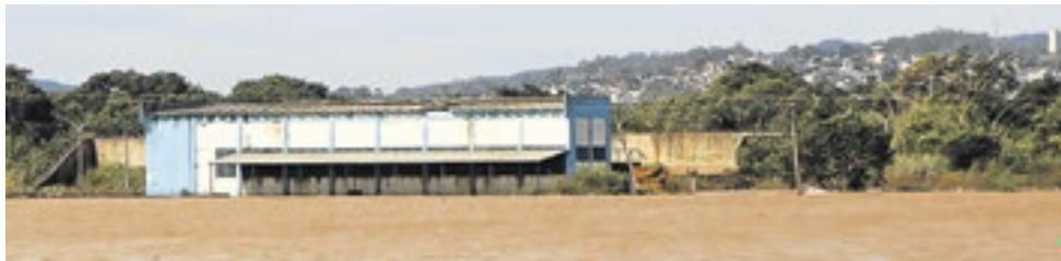
Estruturas da casa de bombas e do dique devem ser avaliadas por especialistas
