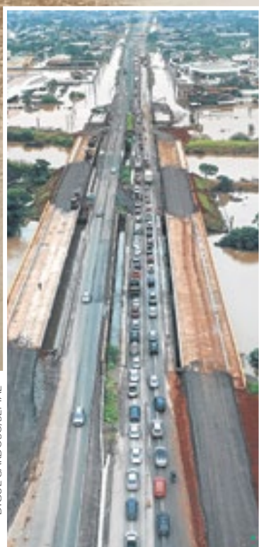
BR-116 teve tráfego aberto nas duas pontes sobre o Sinos
