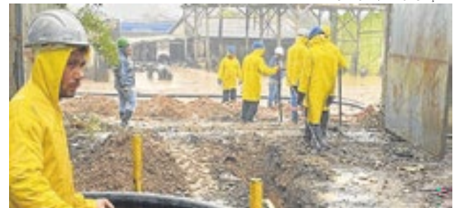
Obras emergenciais estão sendo feitas pela Corsan
