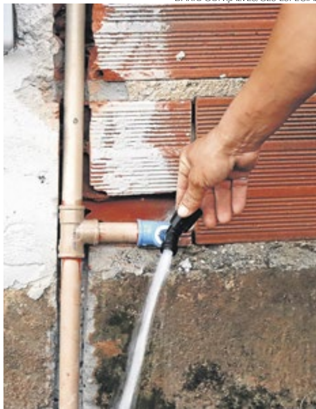
Em Novo Hamburgo, empresa afirmou que a água saindo pelas torneiras da cidade é potável e pode ser consumida
