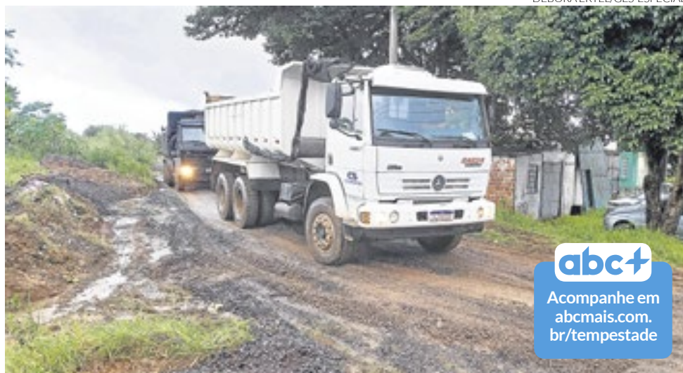
Maquinário acessa o dique para as obras emergenciais pela Rua Manágua
