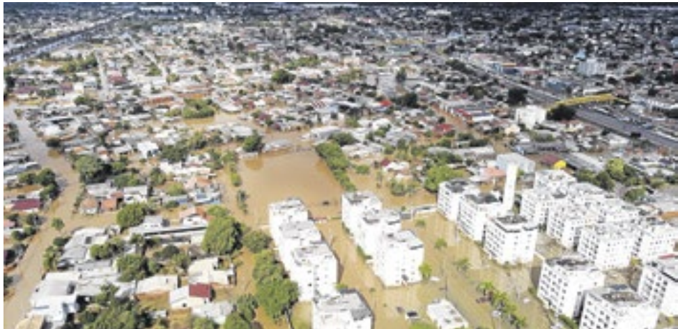
Condomínio e casas no bairro Santos Dumont continuam alagados, mesmo com dia de sol
