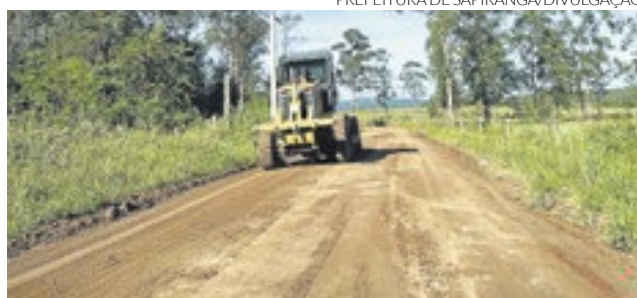
Limpeza das vias na área rural em Sapiiranga
