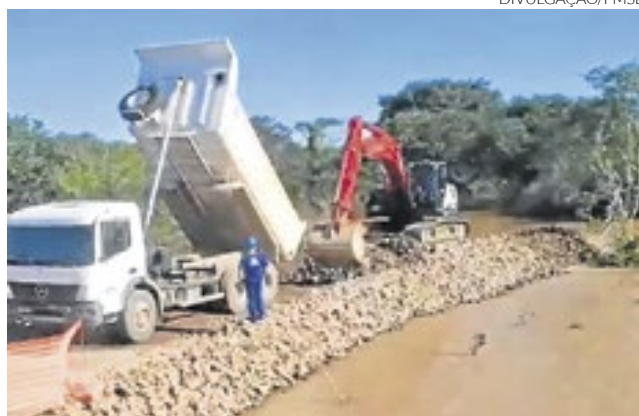
Obras do dique da Vila Brás devem ser finalizadas hoje
