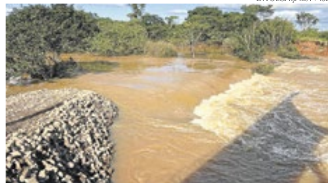
Serviços emergenciais no dique estão em ação
