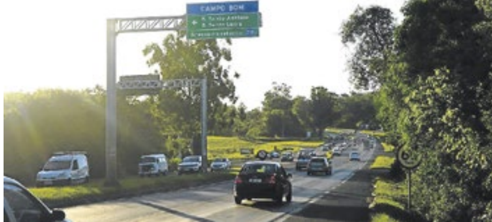
Instalação da iluminação na RS-239 em Campo Bom começou nesta terça (14)
