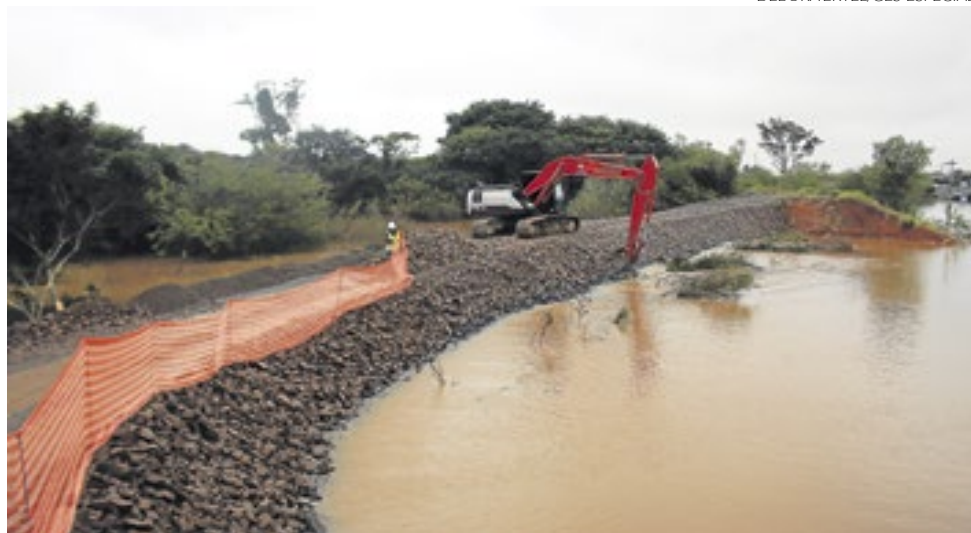
Pedras do tipo rachão foram colocadas ao longo do dique, reforçando estrutura danificada
