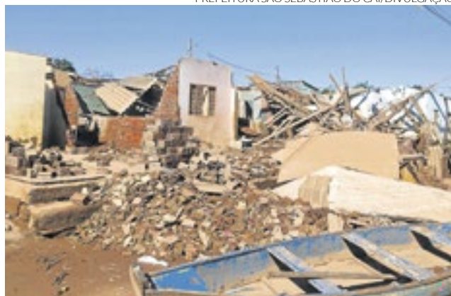
Cheia do rio destruiu casas no bairro Navegantes
