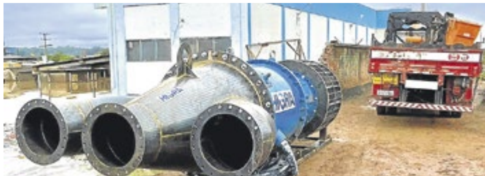
Trabalho para instalação da terceira bomba próximo da Casa de Bombas da João Corrêa
