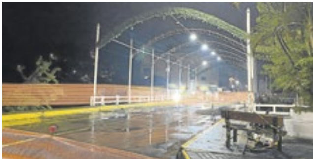
Trânsito está impedido na ponte do Centro de Igrejinha
