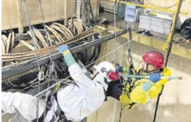
Trabalho da Corsan para volta do abastecimento de água
