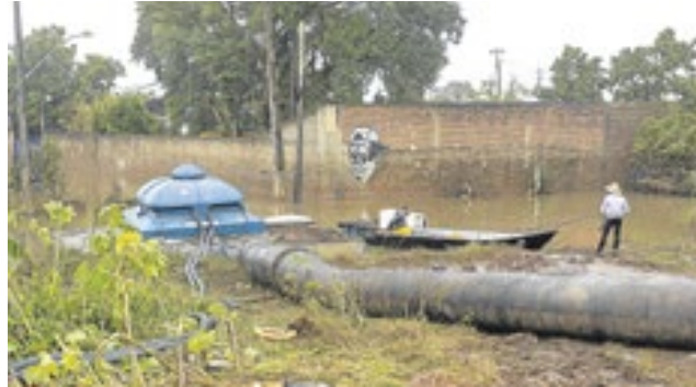
Motobomba instalada no bairro Rio Branco neste domingo
