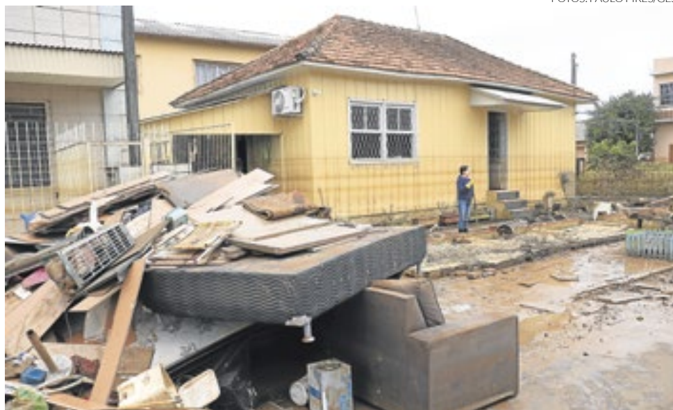
Mesmo alta, a casa de Alice acabou inundada após o rompimento do dique
