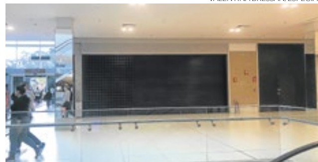
Estrutura será montada onde funcionava restaurante
