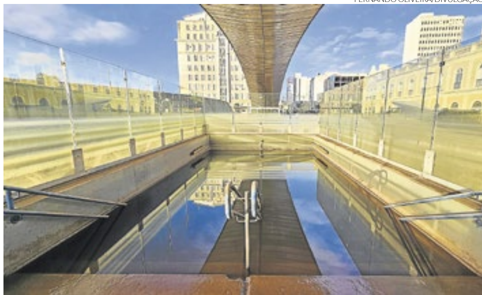
Estação Mercado da Trensurb ainda estava totalmente inacessível na segunda-feira
