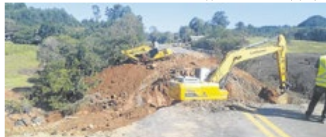
CSG trabalha na recuperação de trecho da RS-240
