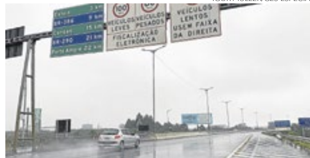
Rodovia do Parque terá elevadas sobre rios e arroios
