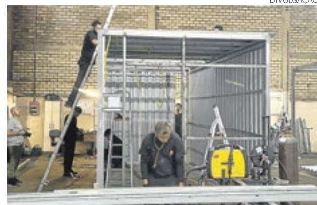
Construção é feita dentro da empresa, na Avenida Mauá
