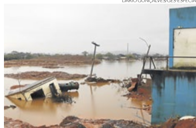
Situação nas imediações da casa de bombas
