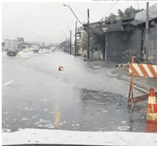
Alagamento na lateral da BR-116, Km 247, em São Leopoldo
