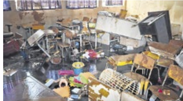
Na Emef Otília, água ocupou 2,5m e causou destruição
