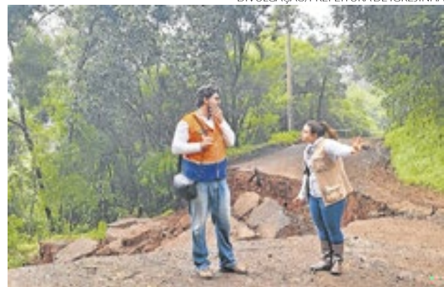
Equipes fez avaliações em áreas de risco
