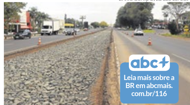
Base com pedra rachão já foi colocada
