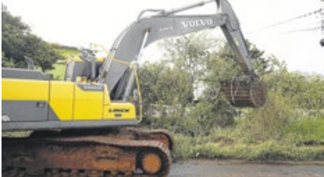
Início do desassoreamento dos arroios em Campo Bom
