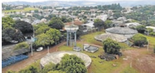
Reservatório R1 não está conseguindo se recuperar
