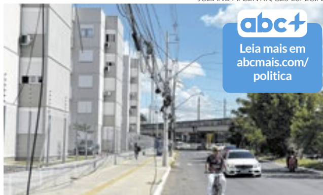
Cabos de Internet e telefone vão precisar de identificação
