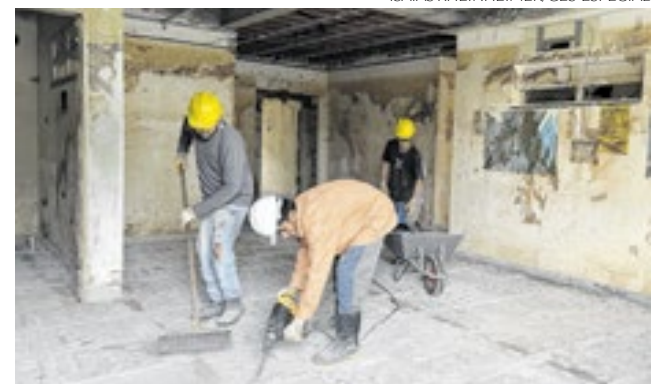
Posto de saúde da Vila Palmeira, no Santo Afonso, em obras
