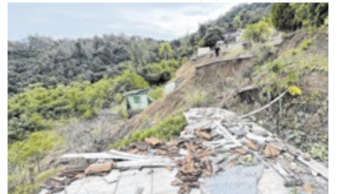
Escombros de casas destruídas por deslizamento de terra
