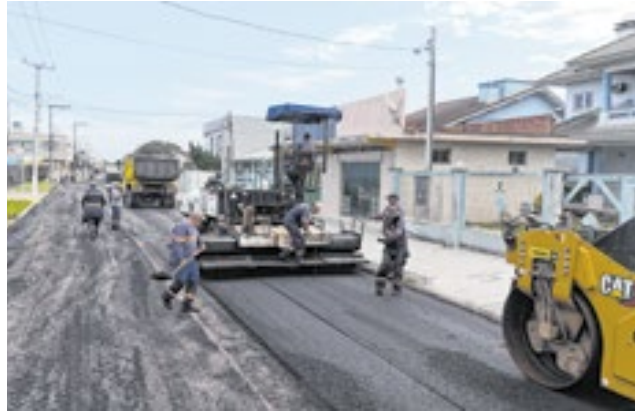
Ações fazem parte de projeto de infraestrutura urbana
